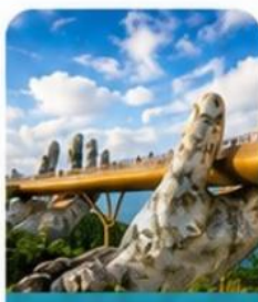
สะพานมือสีทอง
